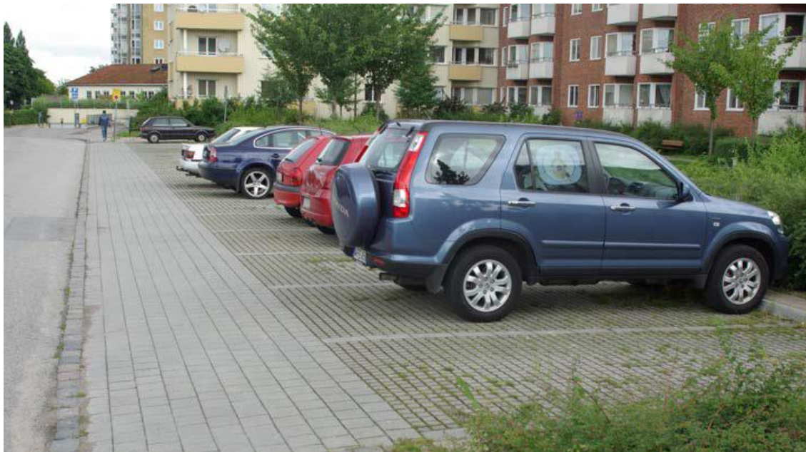
Figur 10. Exempel på genomsläpplig beläggning 19
